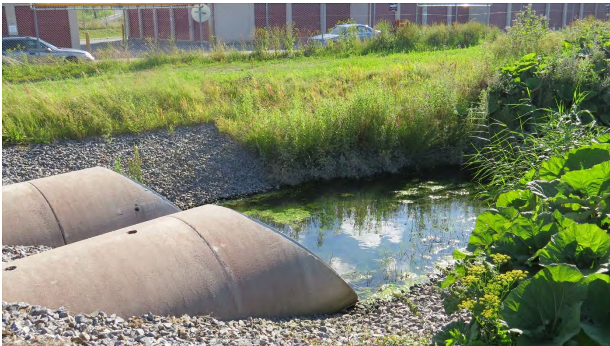
Figur 6. I Norra Råstabäckens nedre västra del vidgas vattendraget till en vattensamling med mycket trådalger innan vattnet rinner vidare kulvertar under parkeringen utanför byggvaruhuset.
