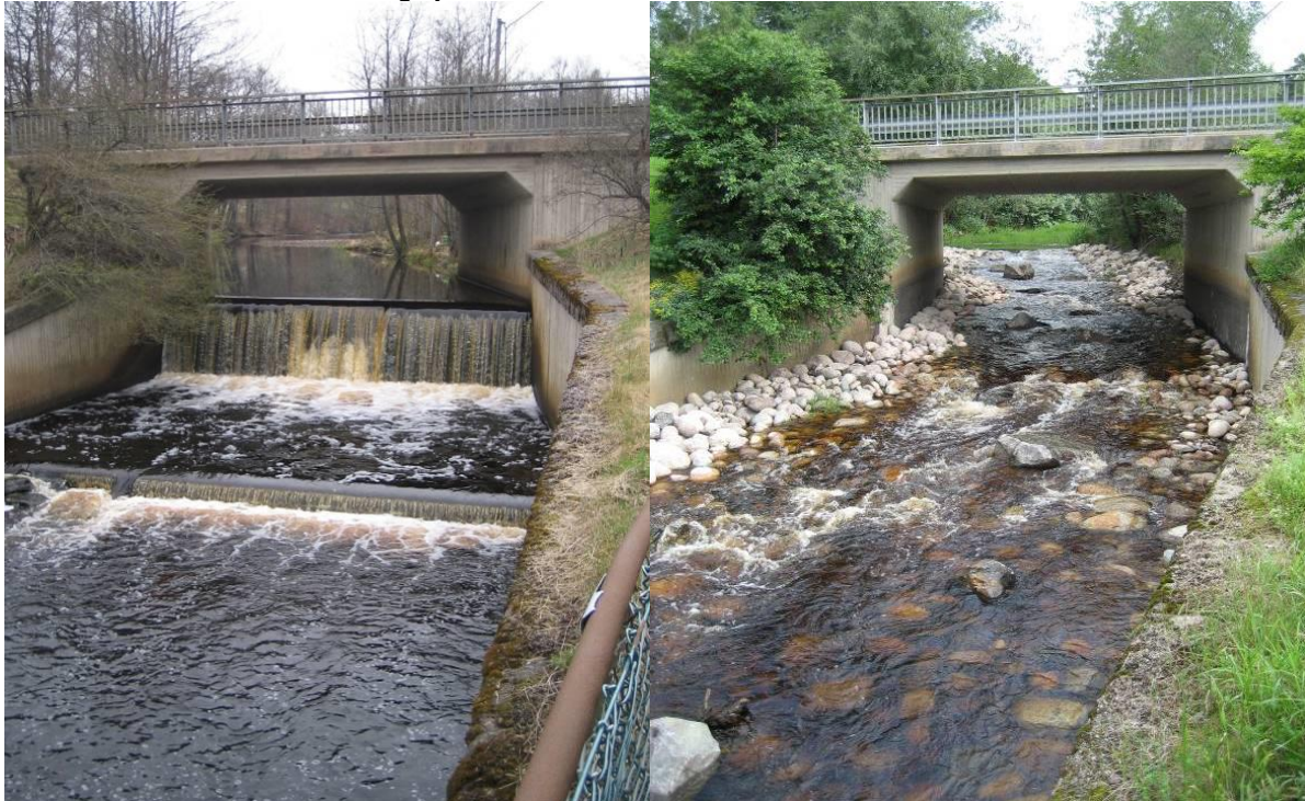
Figur 13. Exempel på utrivning samt bottenuppbyggnad och biopvård av åfåra. Konstruktionen har utsatts för flöden över 10 m 3 /s utan påverkan. Imälven, Karlskoga kommun. Norconsult 2013.
