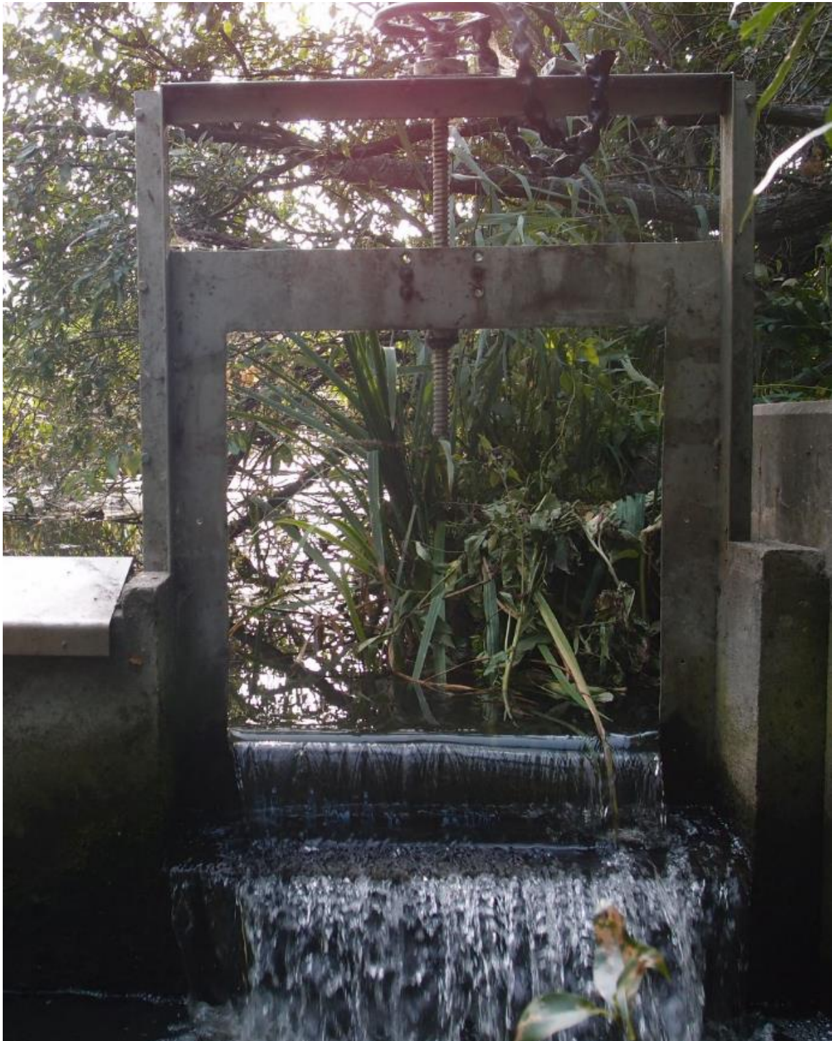
Figur 3. Närbild på det vänstra utskovet som är inrett med en skibordslucka. Uppströmsvy. Norconsult 2017
