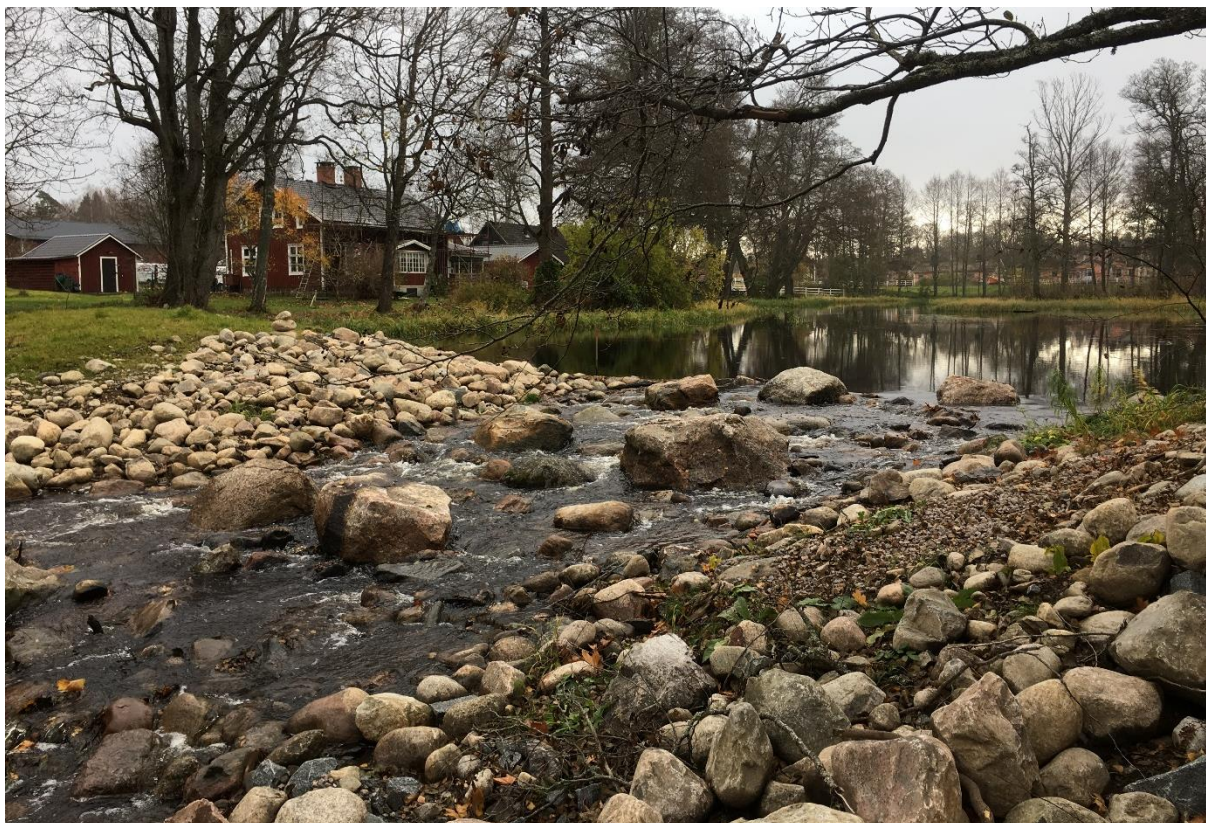
Figur 12. Exempel på naturliknande tröskel. Lägg märke till hur dämningens område uppströms bottenuppbyggnaden har bevarats och åtgärderna utformats så att en lågt lutande fåra skapats som säkerställer naturliga vattenståndsvariationer. Norconsult 2017.
