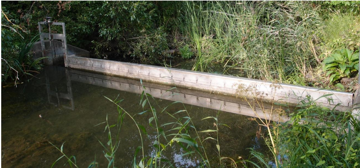
Figur 1. Råstadammen har två utskov. Det vänstra utskovet, sett i strömningsriktningen, består av en skibordslucka och det högra utgörs av en överströmningsdel. Vy nedströms. Norconsult 2017
